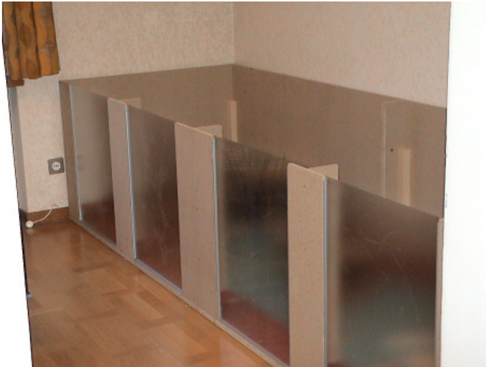
Hier mit eingesetzten Scheiben. Hier sind noch die „Mattscheiben“ drin die aber mittlerweile durch glasklares Acrylglas ersetzt sind.
